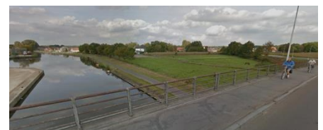
brug over kanaal (Wampenberg)
